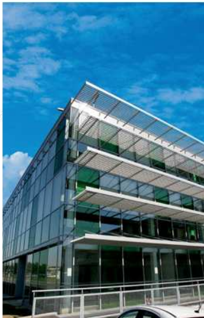
le bel immeuble de Sodexi, devant son "supermarché de l'Express", en zone de fret 2. (foto Sodexi)
